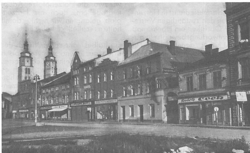
Oberring nach 1945. Im Vordergrund das abgerissene Eckhaus zur Herrengasse (früher Haus Weihrich)
